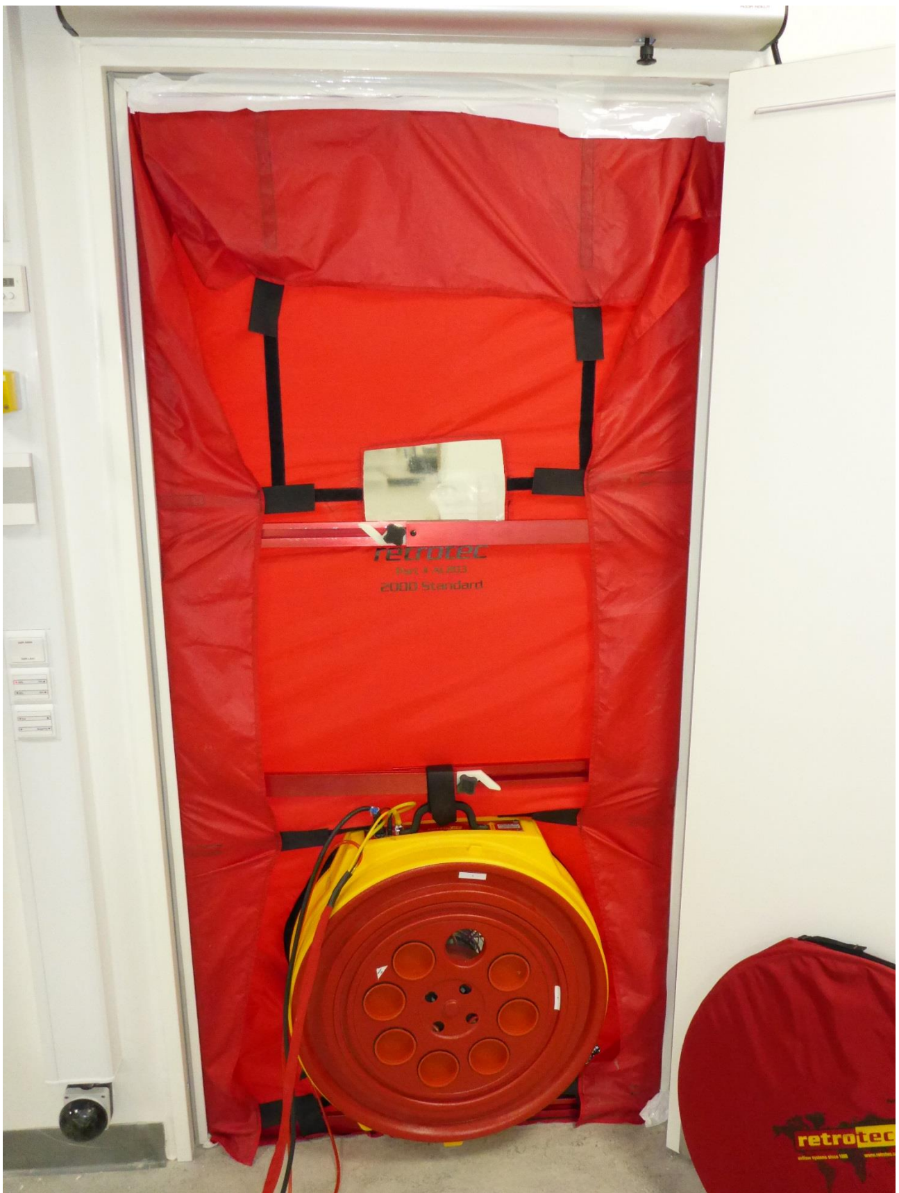
Blowerdoor monteret i dør
